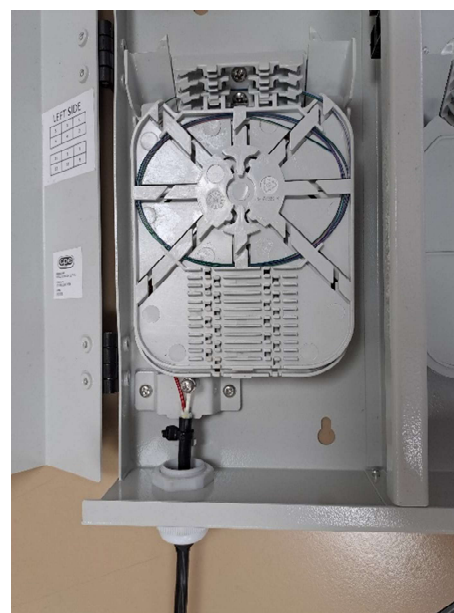
DISPERSIONE DELLA FIBRA NEL SECONDO MODULO DI GIUNZIONE.
