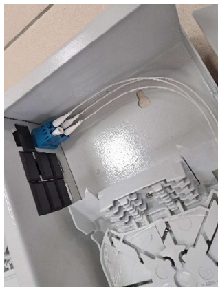
POSIZIONARE I PIGTAILS NELLE RISPETTIVE POSIZIONI.
