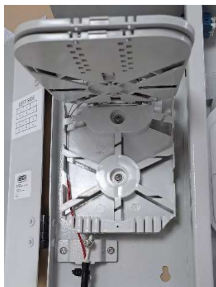
NEL PRIMO MODULO IN BASSO LE FIBRE DA GIUNTARE PER GLI UTENTI DA ALLACCIARE, NEL SECONDO MODULO LE FIBRE IN PARCHEGGIO.
