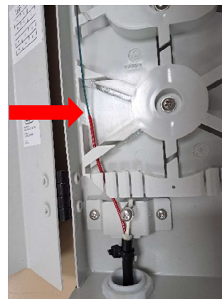
TAGLIARE IL TUBETTO NELLA POSIZIONE EVIDENZIATA E LIBERARE LE FIBRE.
