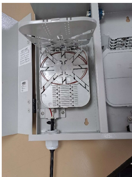
DISPERSIONE DELLA FIBRA NEL PRIMO MODULO DI GIUNZIONE.
