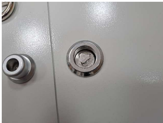
SERRATURA CON IMPRONTA CIRCOLARE A SINISTRA E SERRATURA CON IMPRONTA TRIANGOLARE A DESTRA.
